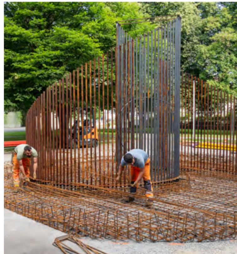
Das Brunnenfundament wird mit Armierungseisen verstärkt.
