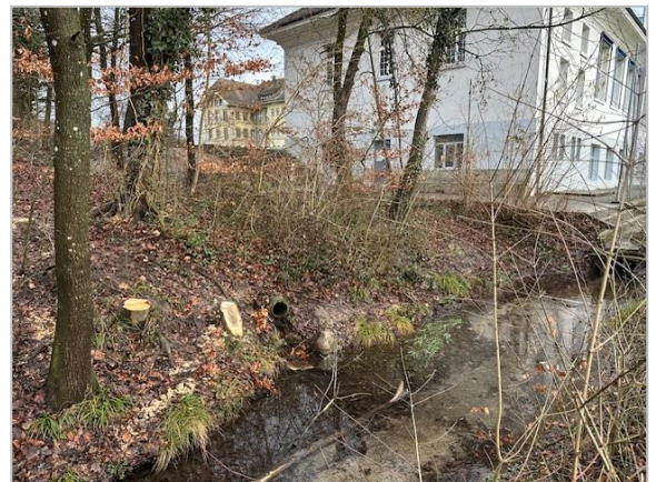
Abbildung 7 Zuflüsse Schulhausbächli zwischen Turnhalle und Weiher. Links: Auszug Leitungskataster, Rechts: Foto der Leitung NB 200
