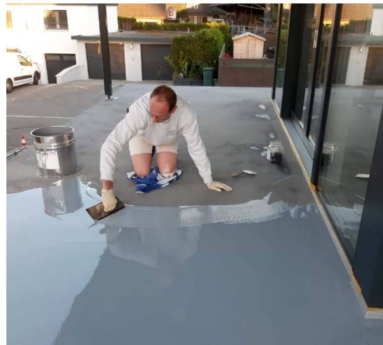
Aufbringen einer Flüssigkunststoff-Beschichtung auf Beton
