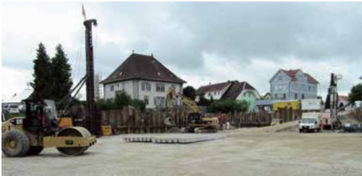
Die Baumeisterarbeiten haben begonnen.
