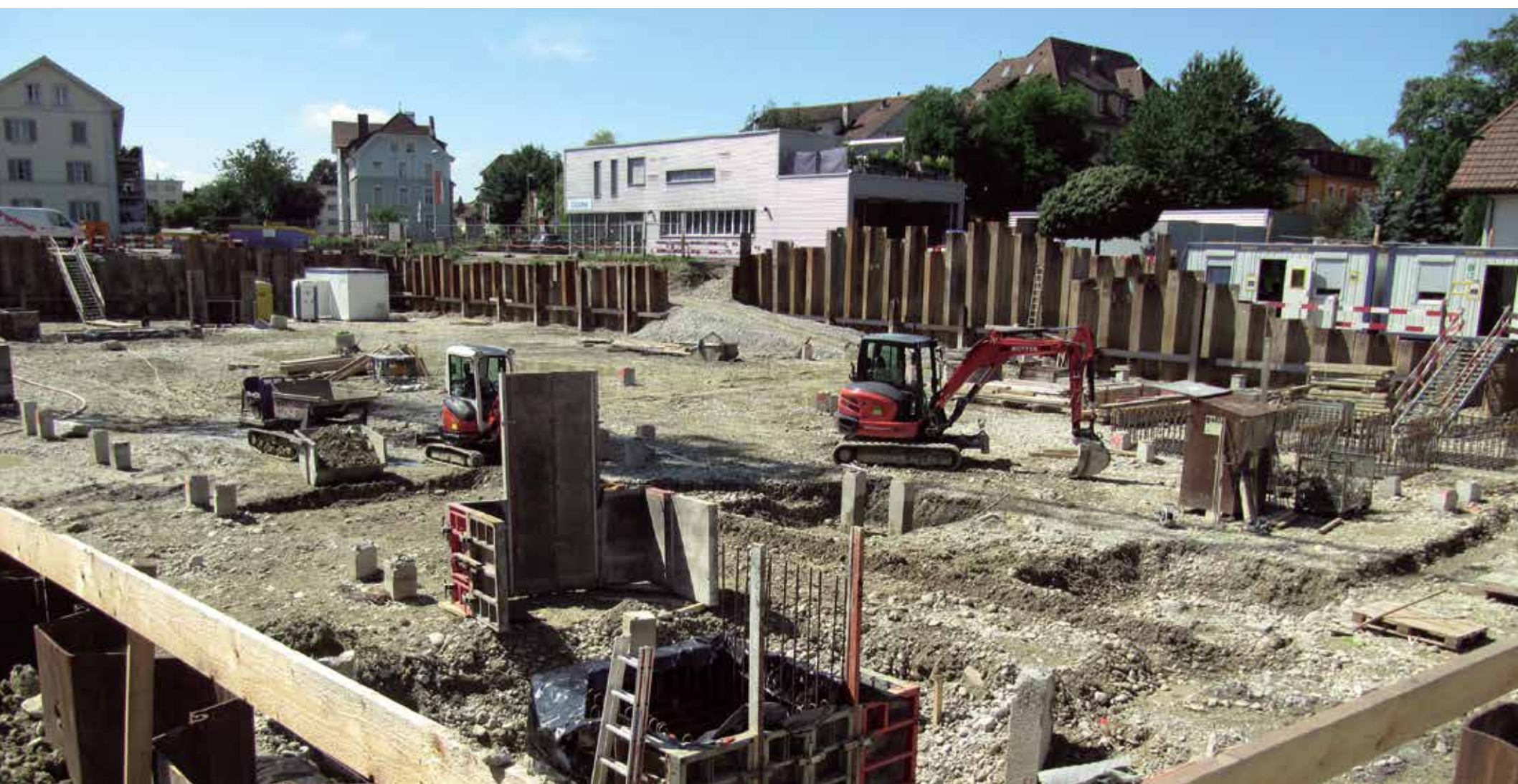
Das Kranfundament ist bereit zum Betonieren.
